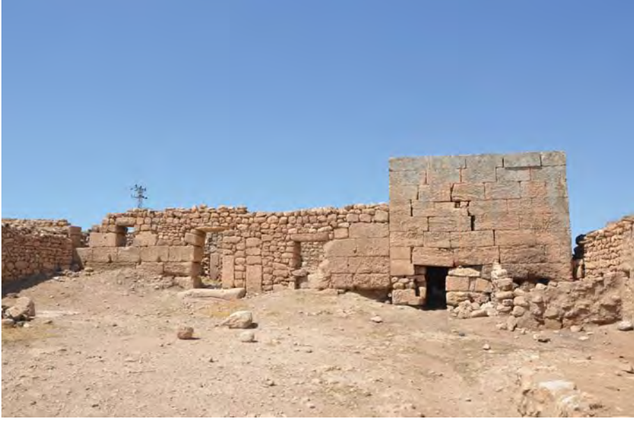
Resim 18: Örenli Köyünde Yer Alan Antik Yapının Güneyden Görünümü (Foto: B. elik)
