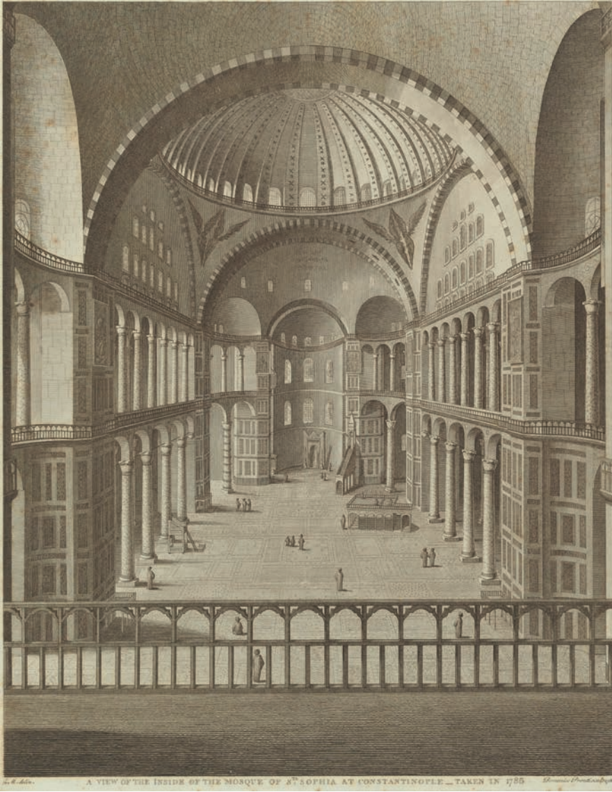
Ek 1. Restorasyon öncesi Ayasofya iç mekanı ve Teknecizâde İbrahim Efendi'nin hat levhaları, Domenico Pronti, G.H. Delin, 1786-88.
