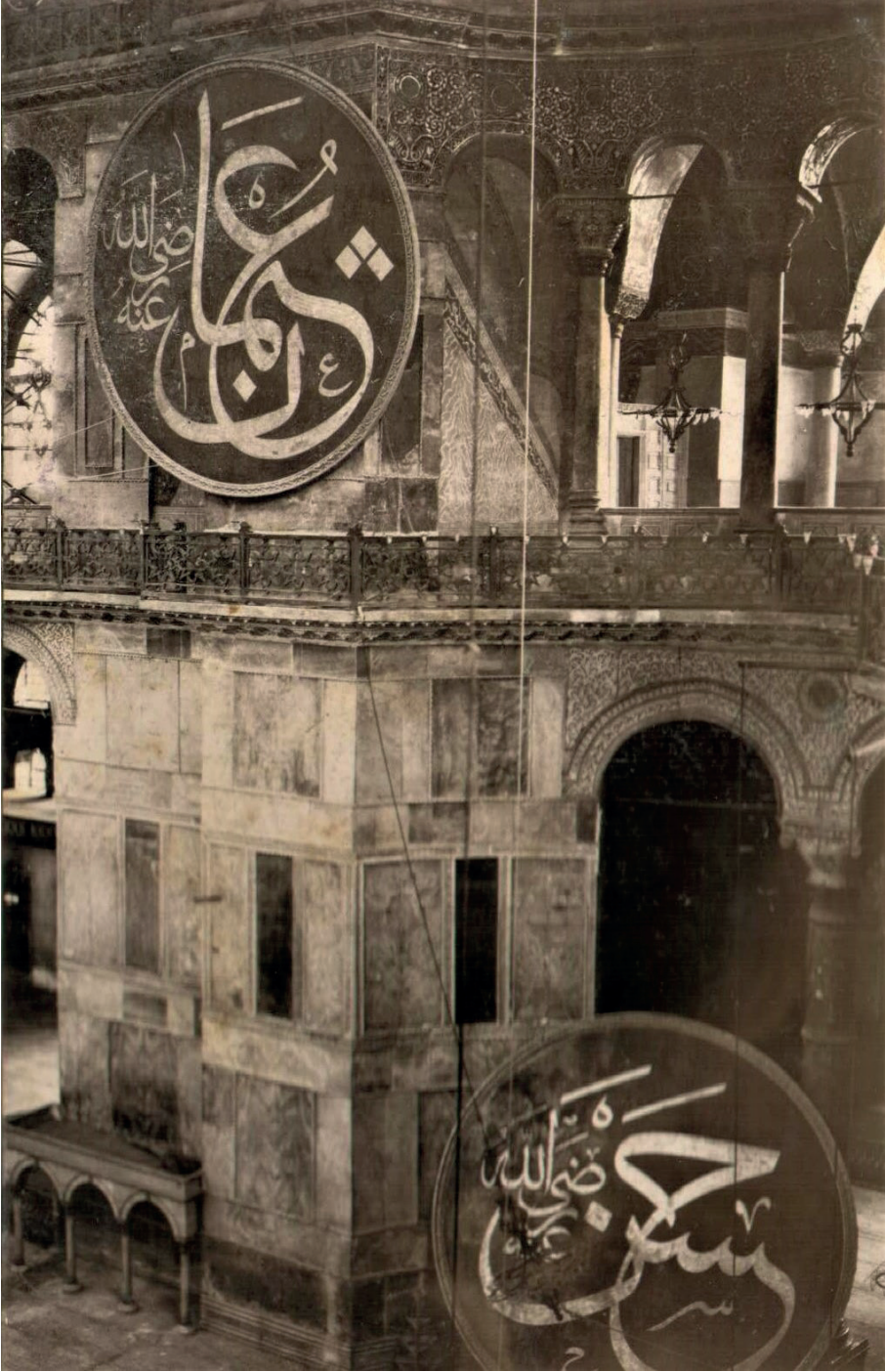
Ek 10. Levhalar yere indirilmesi esnasında.
