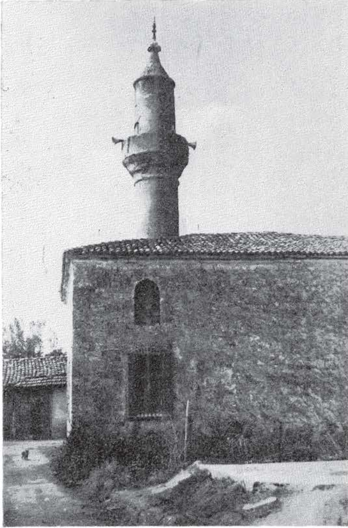
Res.: 9) İmaret Camiinin dođu kenarı. Burada doldurularak örölmüş bir pencere ile yan kanadın duvar üzerindeki izi görölmektedir.
