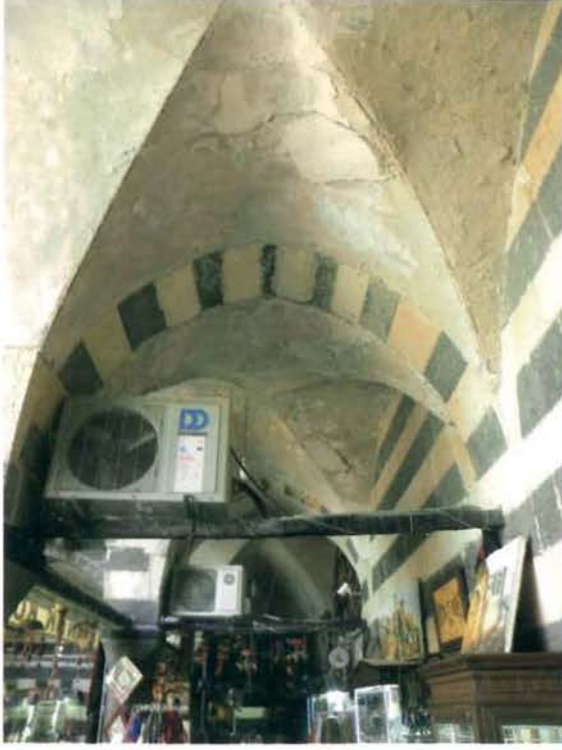
Fotoğraf 21- Handa nemden kaynaklı devam eden sorunlar
