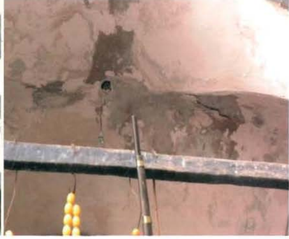
Fotoğraf 21- Handa nemden kaynaklı devam eden sorunlar
