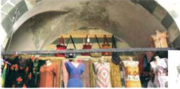
Fotoğraf 21- Handa nemden kaynaklı devam eden sorunlar
