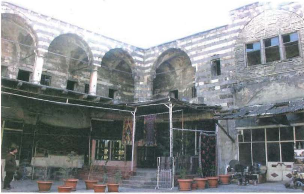
Fotoğraf 5- Hanın avlu cephelerinden görünüş (restorasyon öncesi)
