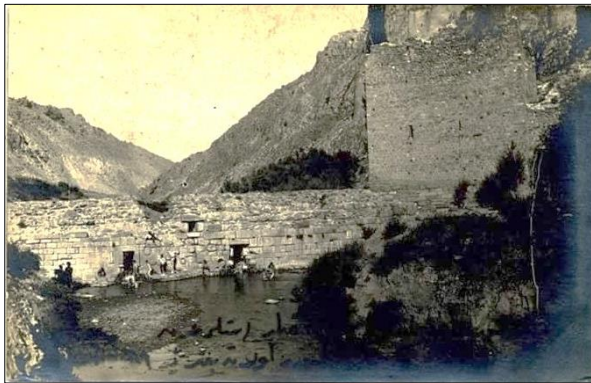
Fotoğraf 37: Roma bendi yıkılmadan önceki durumu (URL 9, 2021).
