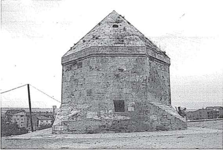
Foto 9: Fatma Hatun Türbesi doğu cephe.
