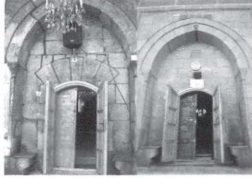
Foto. 8 Cami Kapısının Restorasyonu
