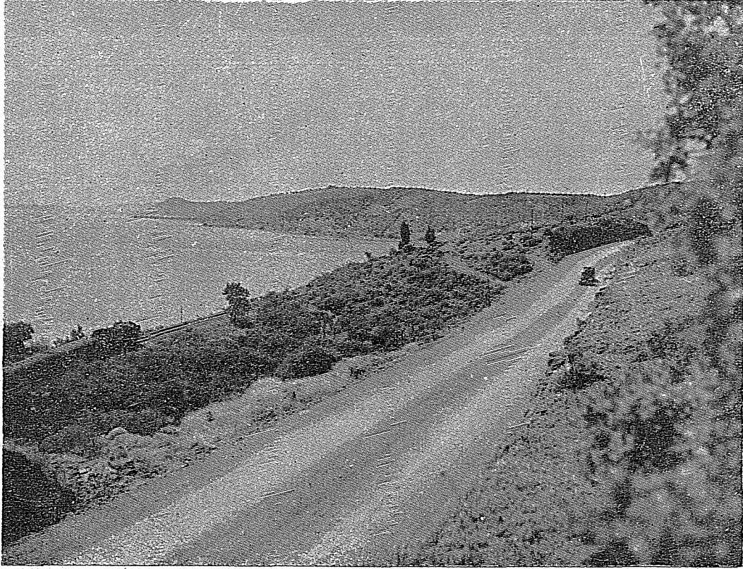
Ankara-Istanbul asfaltı (İzmit'te) La route asphaltée d'Ankara-Istanbul
