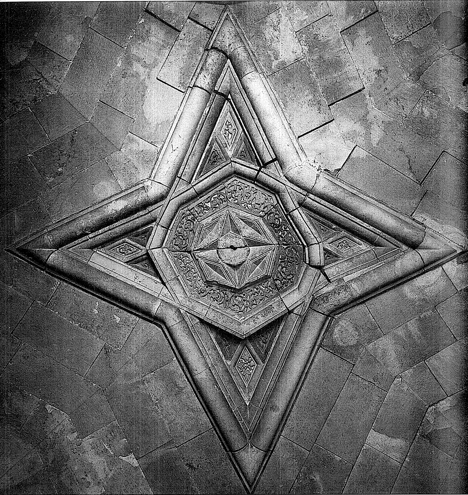
Tonoz Çatı Örtüsü
