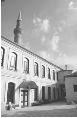
Resim 1: Yeni Cami kuzey cephesi görünüşü
