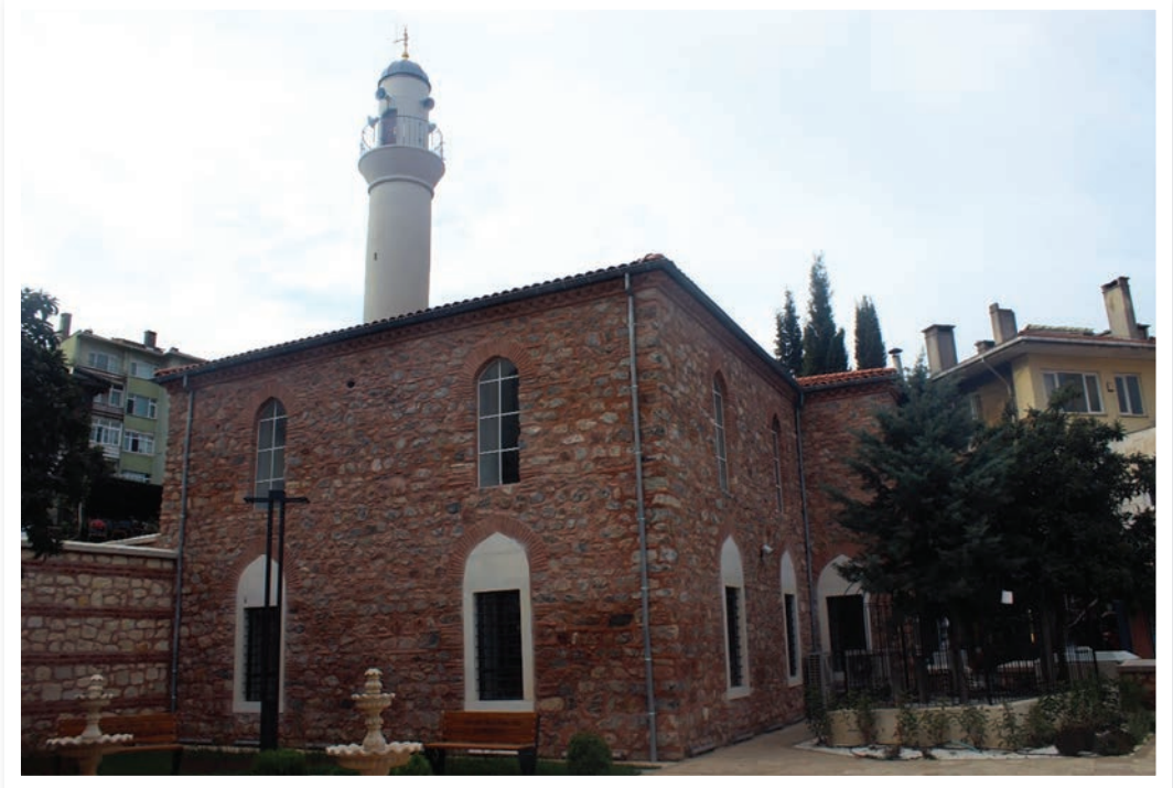
Altında güney su kuyusu bulunan muhdes çardağın 2021 restorasyonu öncesi ve sonrası hali (Fotoğraflar: Zeynep Emel Ekim; A. Sefa Özkaya, 14.11.2021). Çardağın temeli, sağdaki fotoğrafta kırmızı çerçeve ile işaretlenmiştir.
