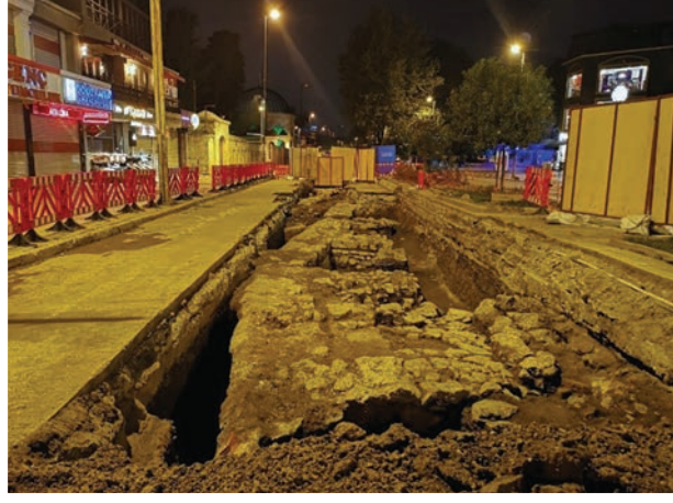
Gülfem Hatun Hani'nın temellerine ait olması muhtemel kalıntılara güneyden kuzeye doğru bakış (Fotoğraf: A. Sefa Özkaya, 21.10.2018).
