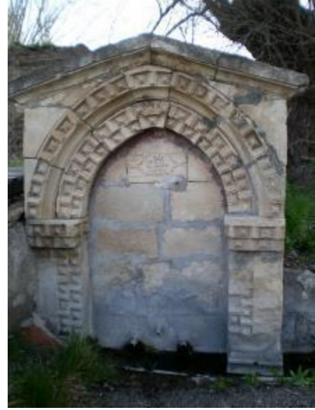
Foto 21: Yazıbeyli Mahallesi I Numaralı Çeşme Cephesi
