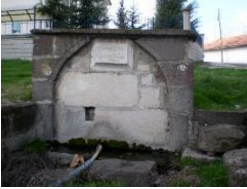
Foto 7: Katibzade Çeşmesi Cephesi
