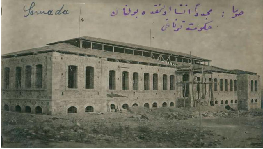
Soma Hükümet Konağı yeniden inşa edilirken
