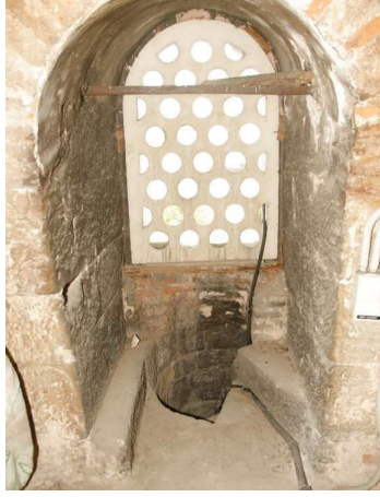
Şekil 31: III. Mehmed Türbesi İç ve Dış Kubbenin Arasına çıkan merdiven.
