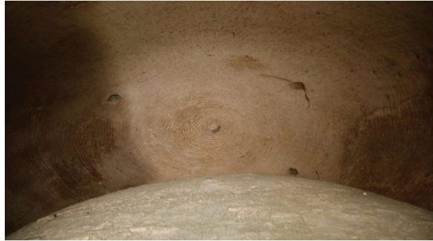
Şekil 33: III. Mehmed Türbesi Kubbe Cidarları Arası Dış Kubbenin içindeki delikler.
