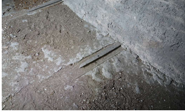
Şekil 34: III. Mehmed Türbesi İç Kubbe ve Dış Kubbeyi bağlayan Demir Gergiler.
