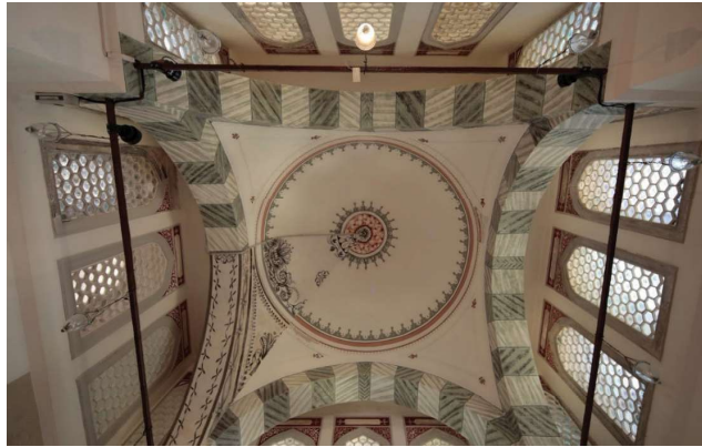
Şekil 38: Şehzadeler Türbesi İç Kubbe Görünüm.
