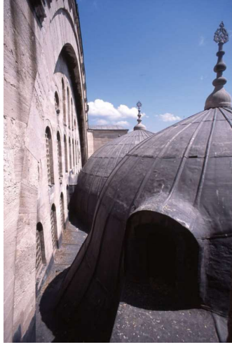
Şekil 7: Süleymaniye Camii çift cidarlı kubbelerinin dış görünüşü ve kubbe iç hacmine giriş kapısı.
