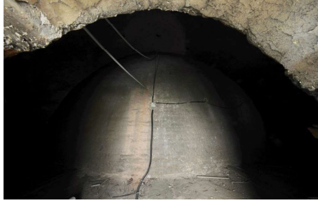
Şekil 32: III. Mehmed Türbesi Kubbe Cidarları Arası Görünüşü.
