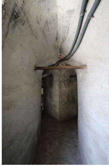
Şekil 18: II. Selim Türbesi Kubbe Geçiş Kesimi Pencere Boşluğu.
