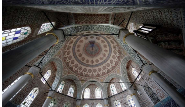
Şekil 30: III. Mehmed Türbesi İç ve Dış Kubbenin Oturduğu Kemerler ve Beden Duvarları.
