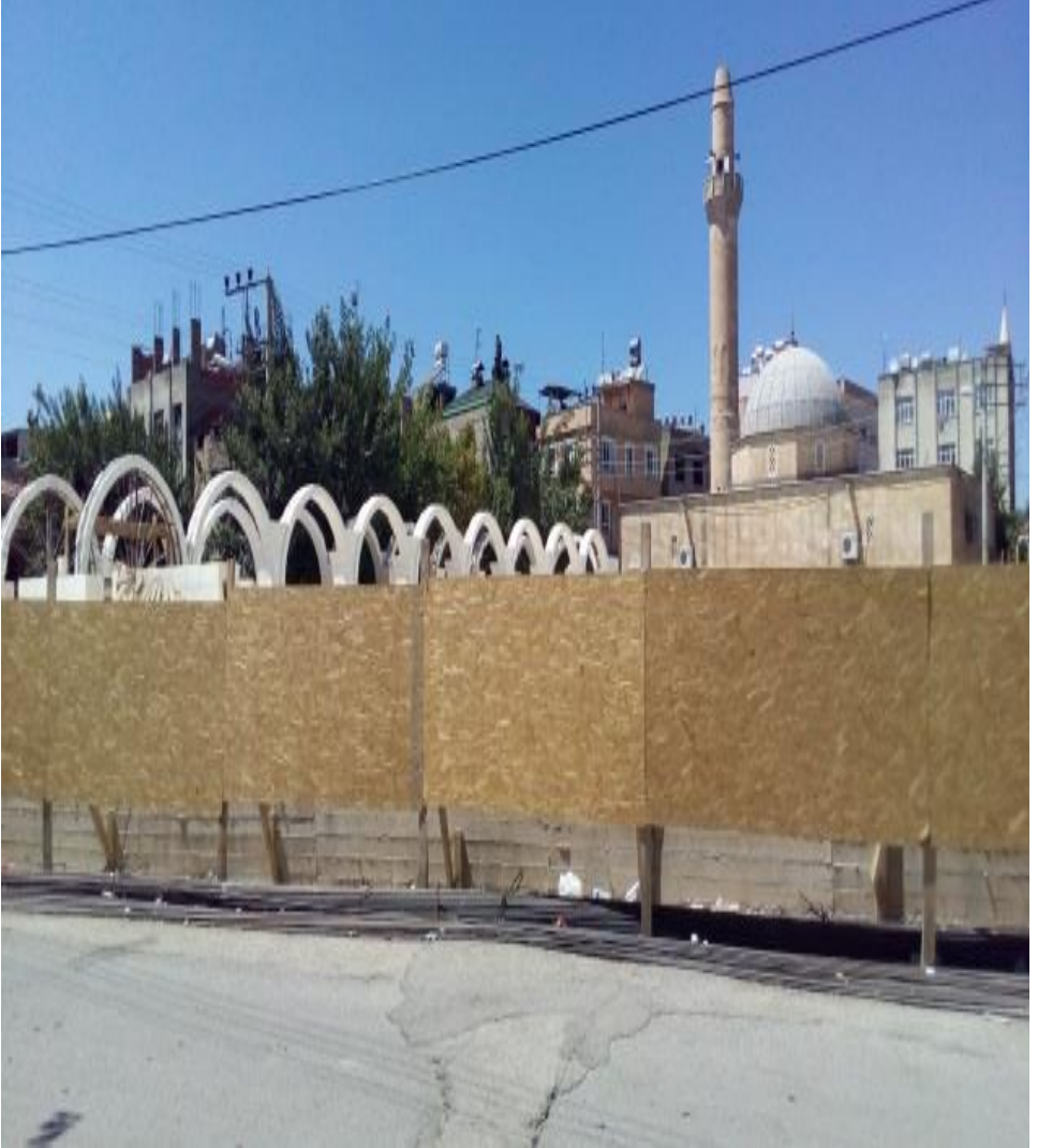
Resim -12: Musalla Camii arka cephesinden bir görüntü, inşası süren Namazgah (Temmuz 2018)
