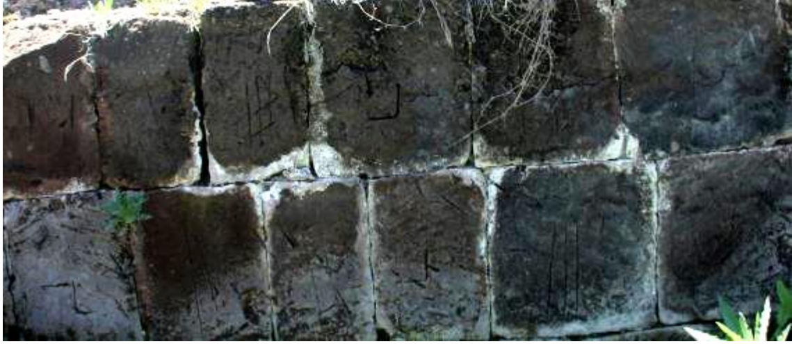
Fotoğraf 3: Çifte Hamam Duvarlarında Yer Alan Taşçı İşaretleri
