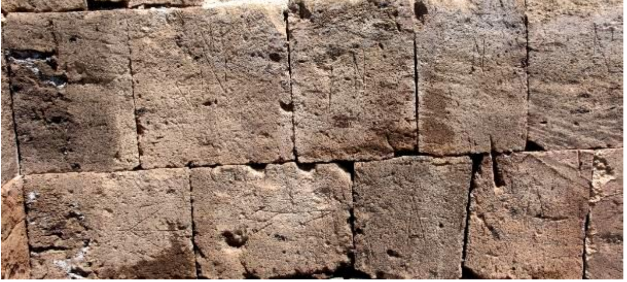
Fotoğraf 1: Selçuklu Zaviyesi Duvarlarında Taşçı İşaretleri
