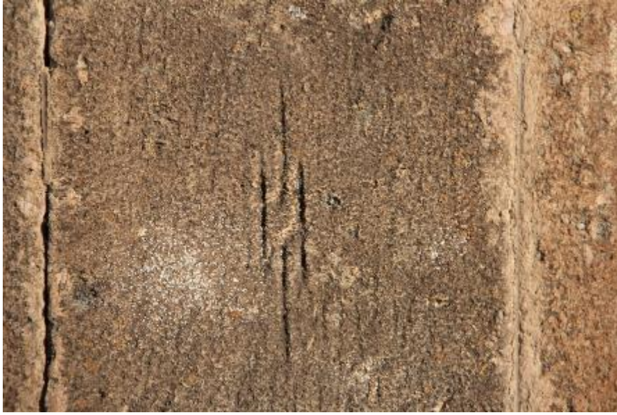
Fotoğraf 13: Ahlat Emir Bayındır Mescdi Cephesinde Yer Alan Taşçı İşareti
